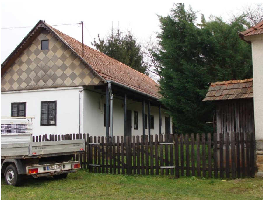
Kékesi út 21. sz. lakóház – helyi védett
