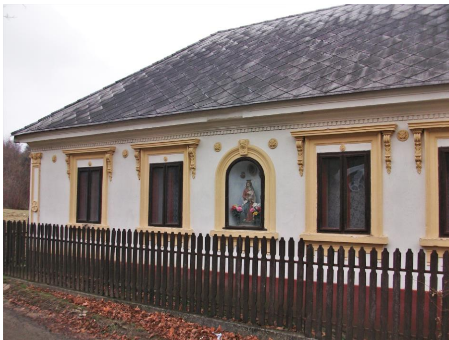
Kékesi út 21. sz. lakóház – helyi védett
