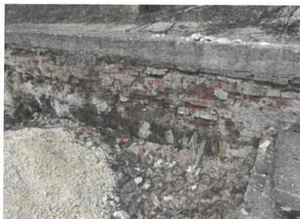
használaton kívüli víziközműhöz kiépített, gyenge állapotú, felújítandó, vagy bontandó támfalak
