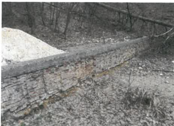
használaton kívüli víziközműhöz kiépített, gyenge állapotú, felújítandó, vagy bontandó támfalak
